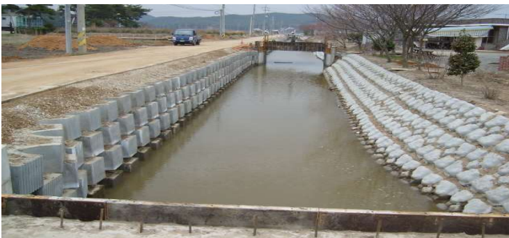
〈그림 III-3-8〉 인공적 콘크리트 호안 설치 지양
