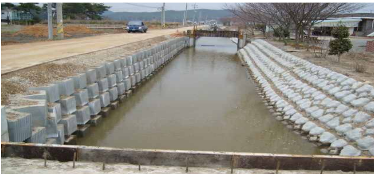
&lt;그림Ⅲ-3-8&gt; 인공적 콘크리트 호안 설치 지양
