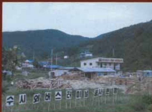
▲ 1982년 시외버스터미널 신축 공사 현장
