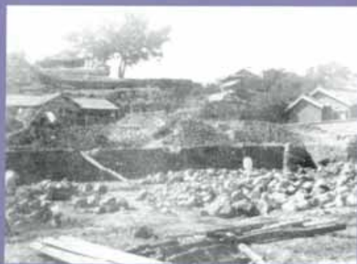
▲ 1950년 여수우체국 신축 공사
