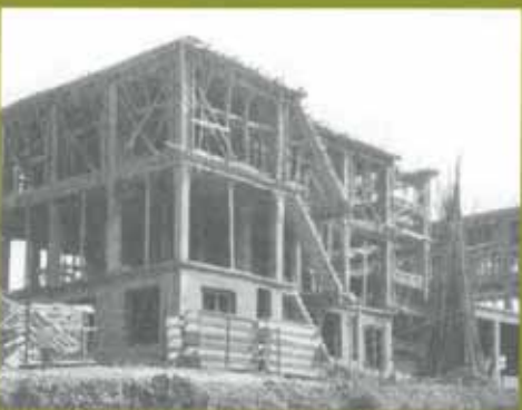
▲ 여수관광호텔 건축공사 현장
