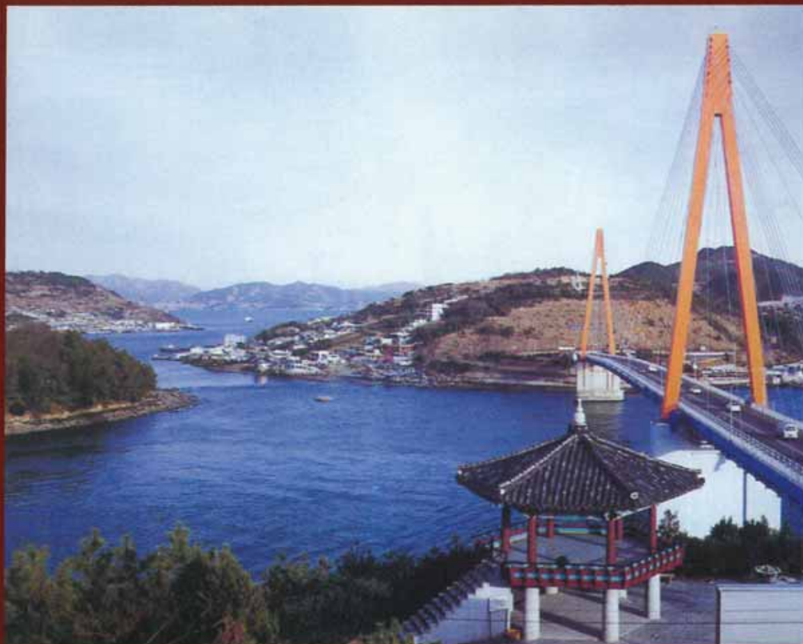
▲ 남산동과 돌산읍 우두리를 연결하는 국도 17호 선상의 다리로 길이 450m, 폭 11.7m, 교각높이 62m의 사장교인 돌산대교
