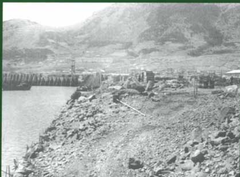
◀ 1976년 국동어항 공사 현장
