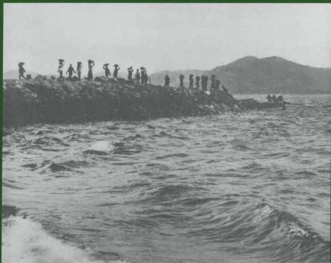
▲ 1971년 거문도 동도 선착장 공사
