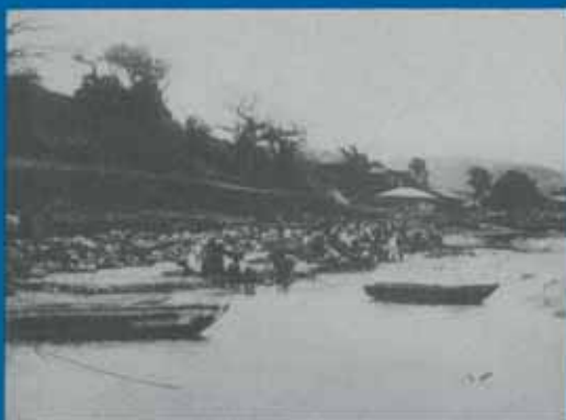
▲ 1940년대 거문도 동도 죽촌 호안공사
