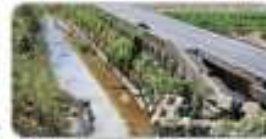
하천 제방 유실
