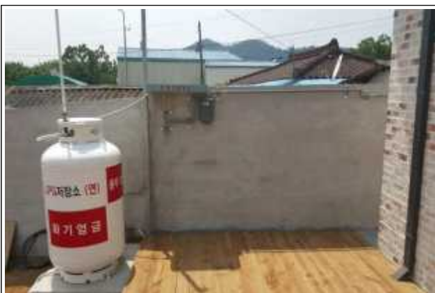
주택 내 소형저장탱크 설치
