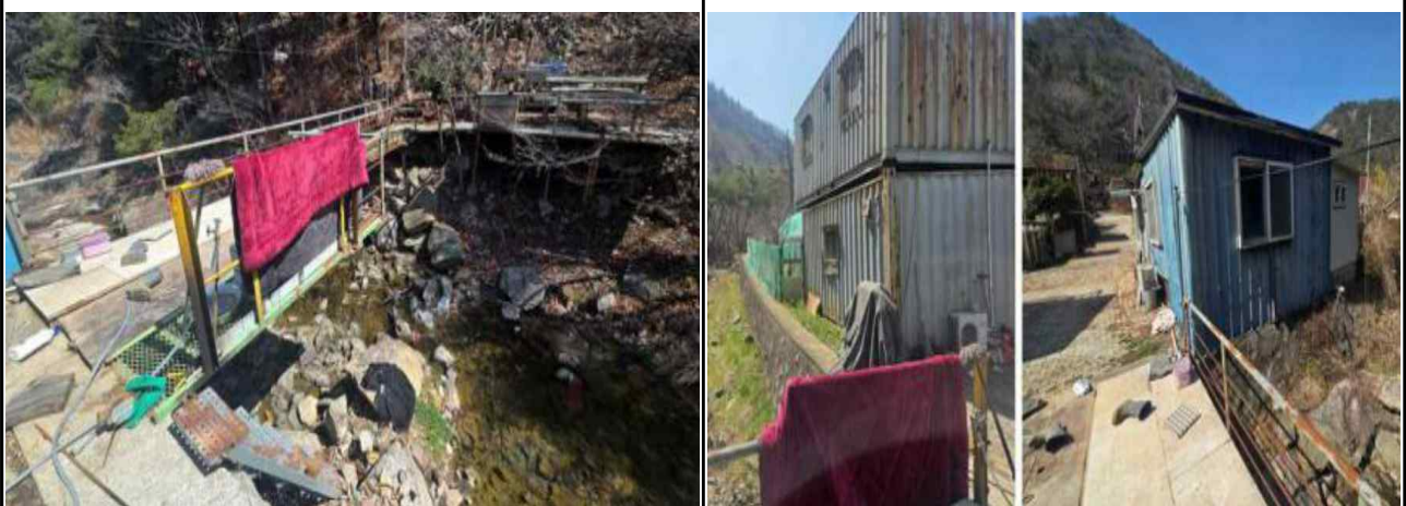
하의곡천(001) 전남 여수시 소라면 봉두리 1418번지 평상 평상 1개소, 가설 및 건축물 4개소, 기타(가설 교량, 물건 적치, 계단) 3개소
